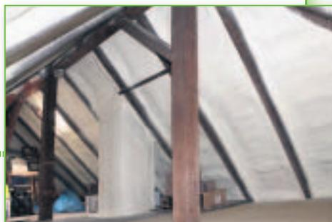
Sprühschaum-Dämmung – wie hier unter einem Dach – bewährt sich nicht nur in Wohnhäusern. Auch zur Isolierung gegen Wärmeverluste zum Keller sowie in Werk- und Lagerhallen ist sie ideal. Egal wie uneben, sie haftet auf nahezu jedem Untergrund.
